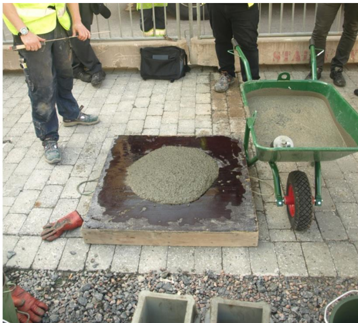
Figur 24. Provning av betongens konsistens och flytförmåga vid gjuttillfället.
