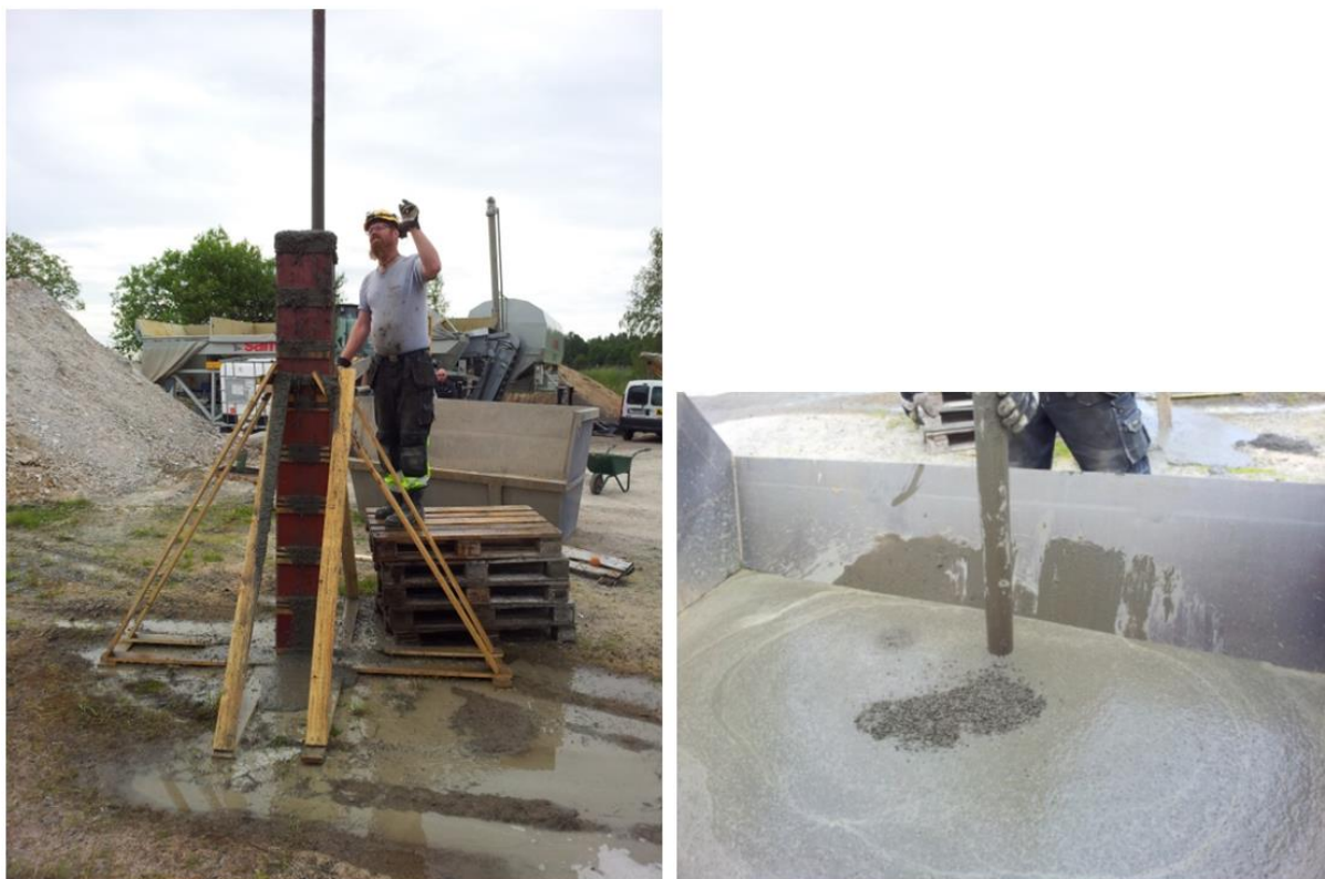
Figur 21 Provgjutning nr 1 med traditionell pumpning i form. Stenseparation i betongmassan efter 22 m fall genom pumpslangen.
